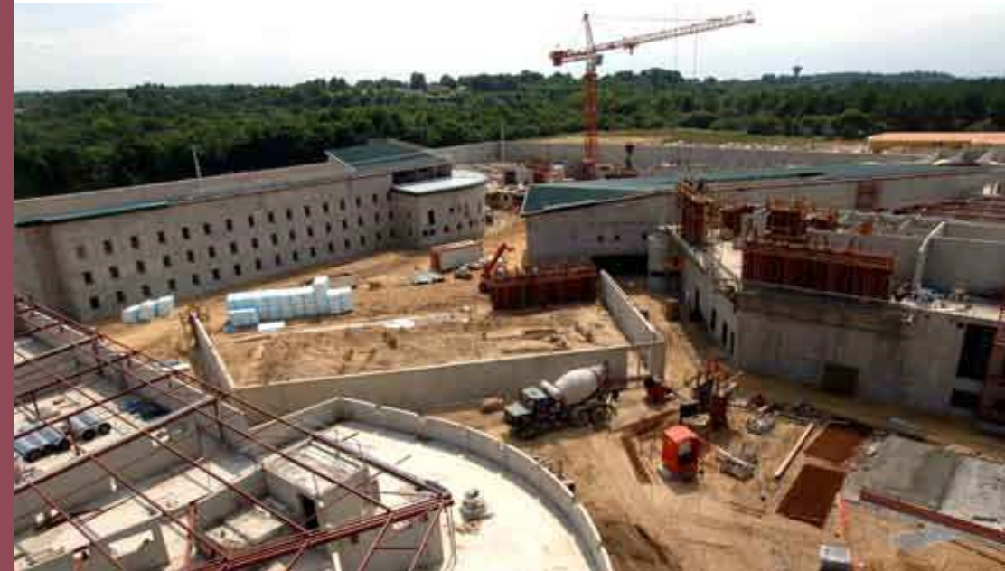
^ Photographies du chantier
